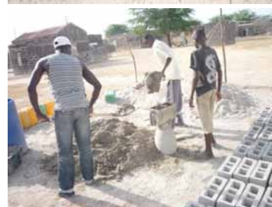
Von oben nach unten: Ousmane Bâ begleitet den Transport von Zement nach Baoût. Besprechung über den Bau des Ladens mit Dorfcchef und beteiligten Personen. Der Maurer misst und legt den Grundriss nach Plan fest. Fabrikation der Ziegel aus Sand und Zement.
